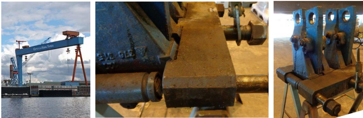
Abbildung 28: 900-Tonnen-Portalkran (links); Schienezange (Mitte und rechts) 50
